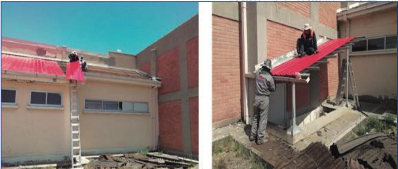
Provisión y colocado de cubierta galvanizada N° 28. Foto: Naabol (Cortesía)
