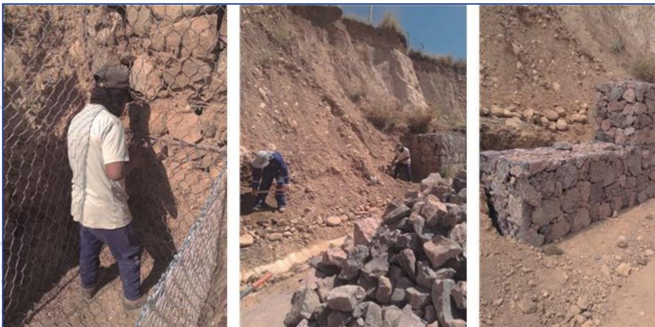
Armado de Gaviones 2x1x1 metros. Foto: Naabol (Cortesía)
