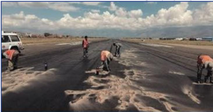
▲ *Sello de fisuras, reparación y bacheo de deformación y hundimientos.
